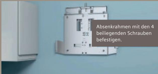
Absenkrahmen mit den 4 beiliegenden Schrauben befestigen.
